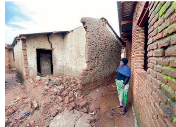
Viele Häuser sind aus Lehmziegeln gebaut. Bei Starkregen stürzen sie häufig ein.
